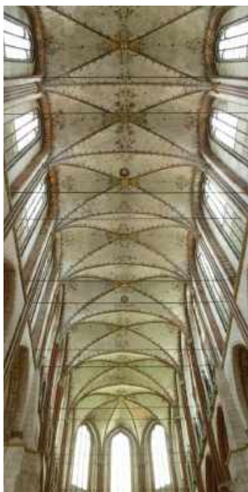
Backstein-Rippengewölbe in St. Marien
