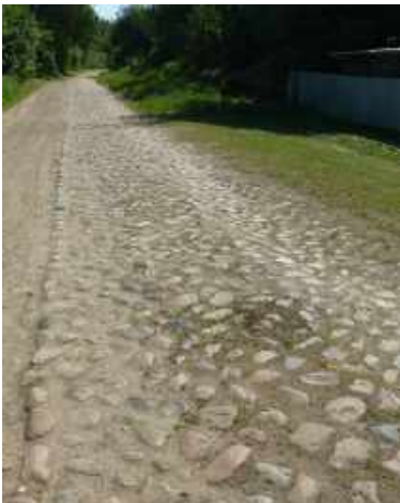
Salzstraße, an sandigen morastigen Stellen war sie gepflastert
