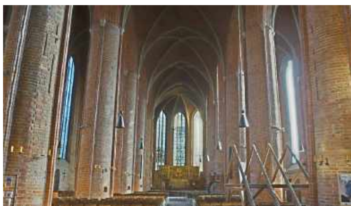
Mittelschiff nach der Instandsetzung in den 50er Jahren
