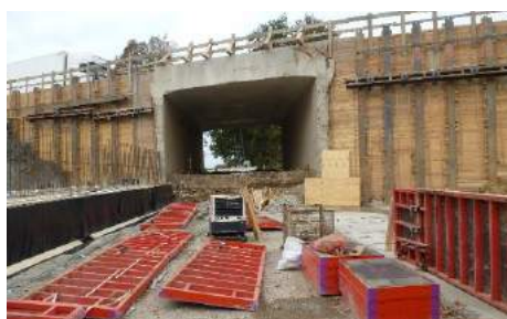
Pilgerweg und Baustelle
