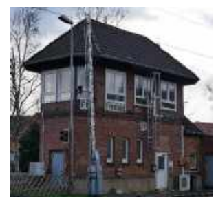
Stellwerk und Ausguck für den angehenden Eisenbahner
