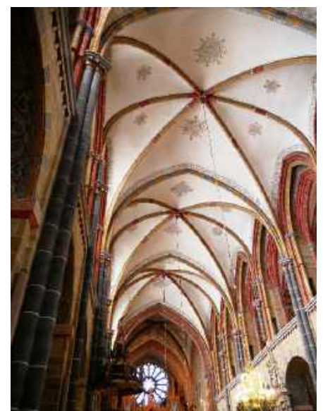
Gewölbe in 20 m Höhe
