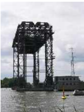
Mittelteil als Hubbrücke des ehem. 360m langen Brückenbauwerks
