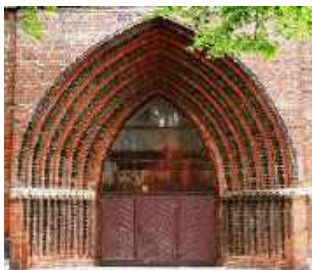
Westportal mit glasierten Backsteinen
