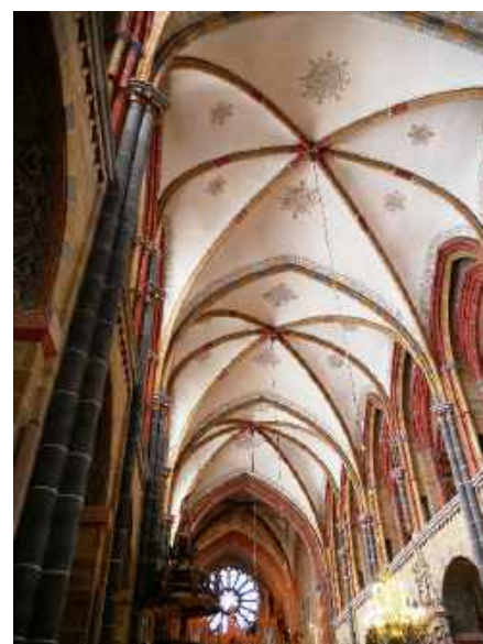
Gewölbe in 20 m Höhe
